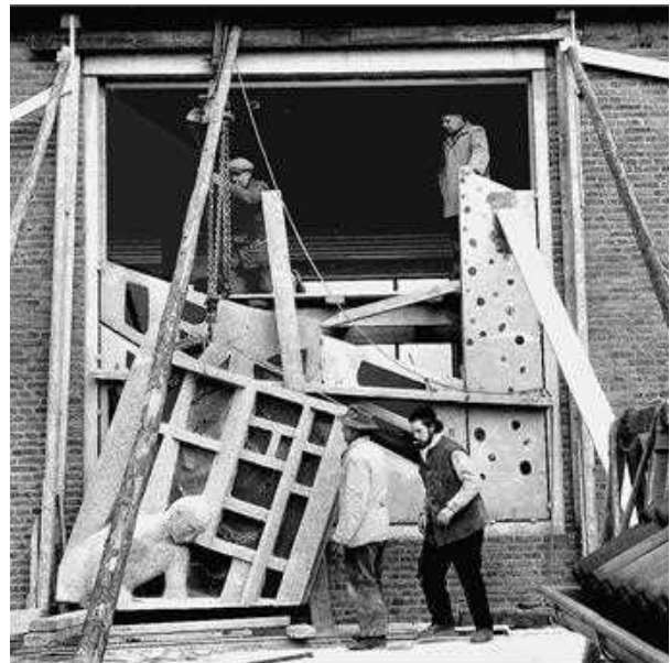
1958. Een deel van het betonreliëf wordt omhoog getakeld. Moderne mobiele kranen voor zwaar hijswerk waren er nog niet. De man met baard is Marius van Beek. Fotocollectie: Henk Hanselman
