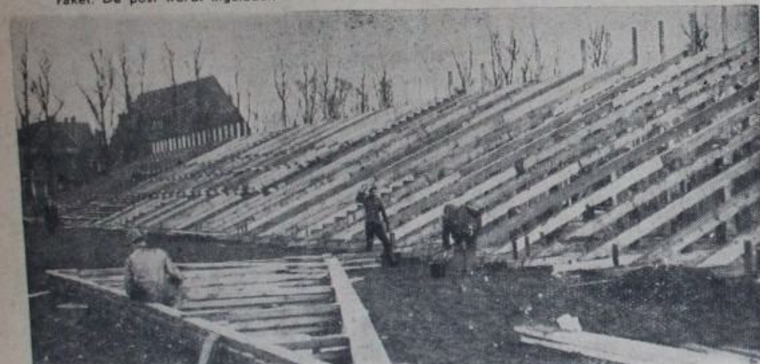
Voor den voetbalwedstrijd Feyenoord—Ajax te Rotterdam wordt met man en macht gewerkt aan de permanente staantribune op het Feyenoord-terrein
