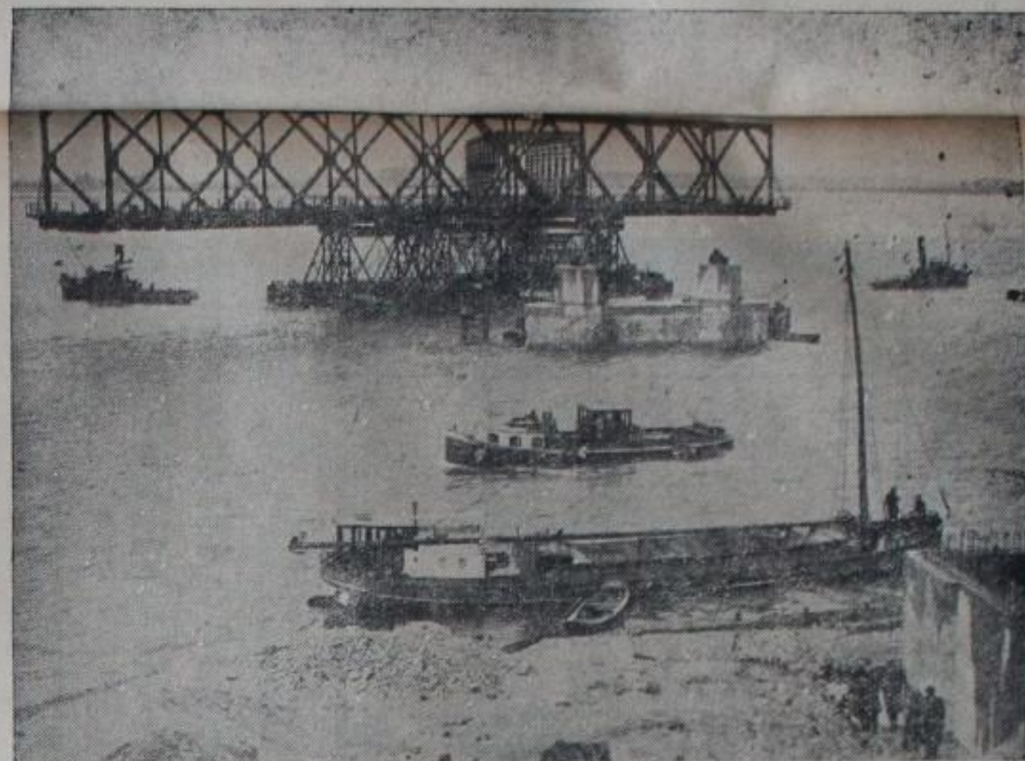
Op het Hollandsch Diep — De tweede overspanning voor de nieuwe Moerdijkbrug nadert de plaats van bestemming — Rechts op den achtergrond onderscheidt men nog een gedeelte van de bestaande brug
