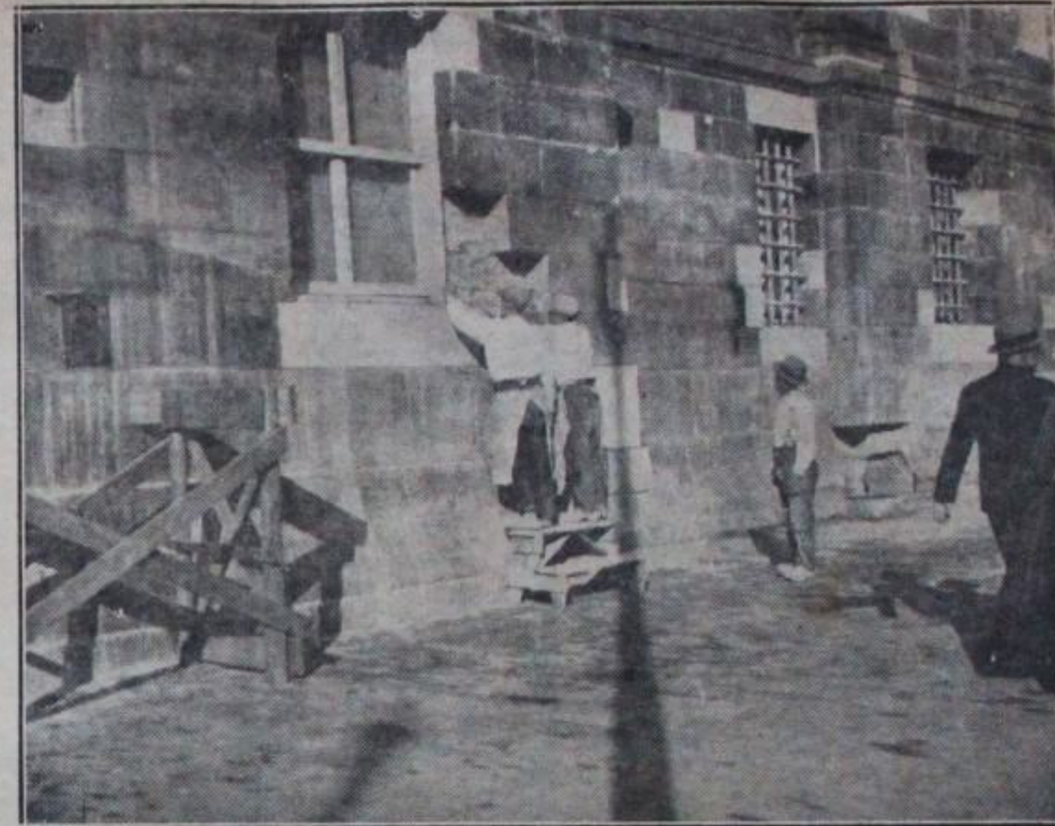
Aan het Koninklijk paleis op den Dam te Amsterdam is men thans bezig met reparatiewerkzaamheden. — Een kijkje op het werk
